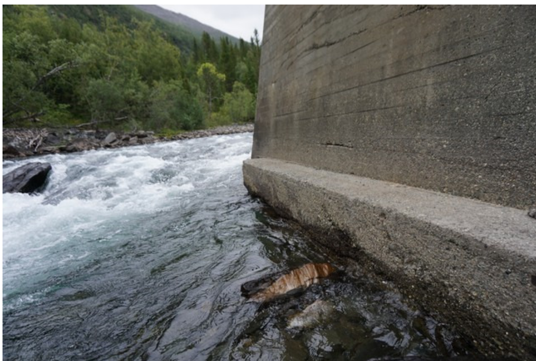
Bilde 8: Pilar akse 2; Utvasking
