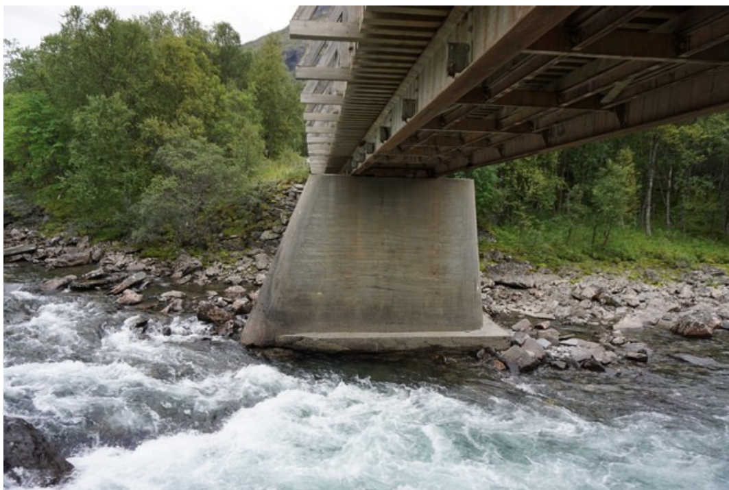
Bilde 7: Pilar akse 2; Utvasking
