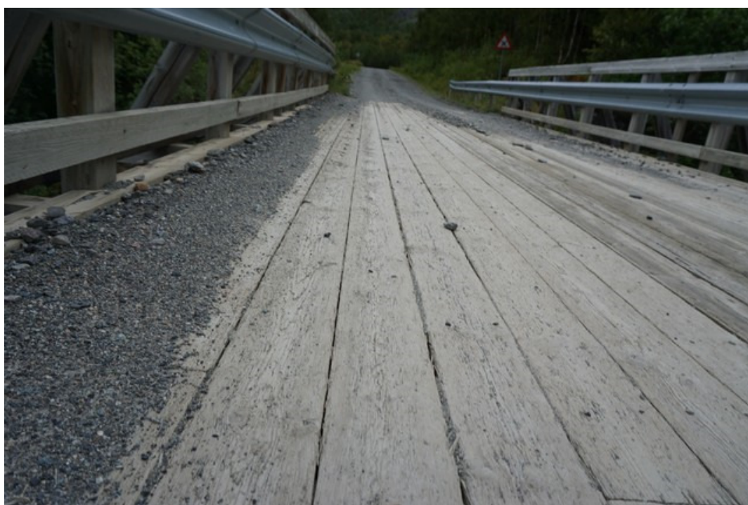
Bilde 16: Slitelag; Oppflising og sporslitasje
