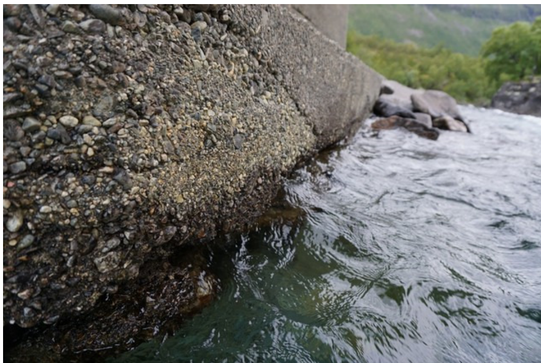
Bilde 9: Pilar akse 2; Utvasking
