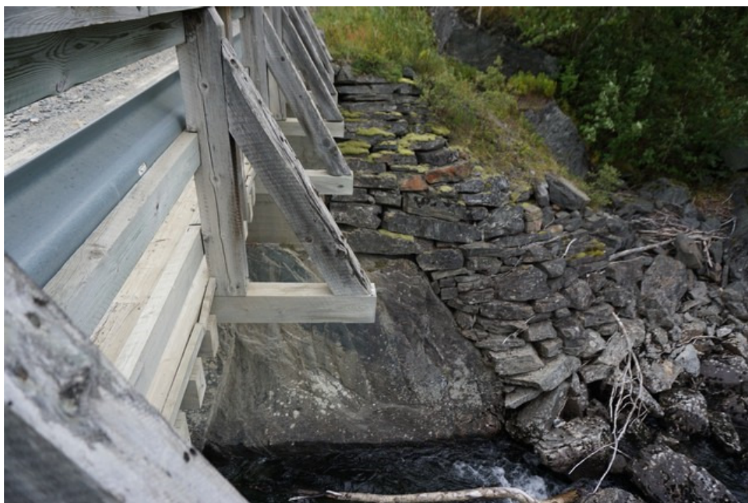
Bilde 2: Fylling; Mindre utrasing akse 3
